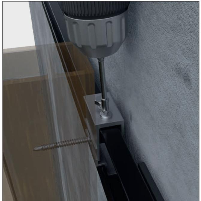
**SCHRITT 5** Justieren Sie die Vertikalität des Brise Soleil mit der Einstellschraube M6x20mm ein. Schrauben Sie dann den NV3-Clip mit einer 5,5 x 32 mm großen Schraube mit einem langen Stück auf die Schiene.
